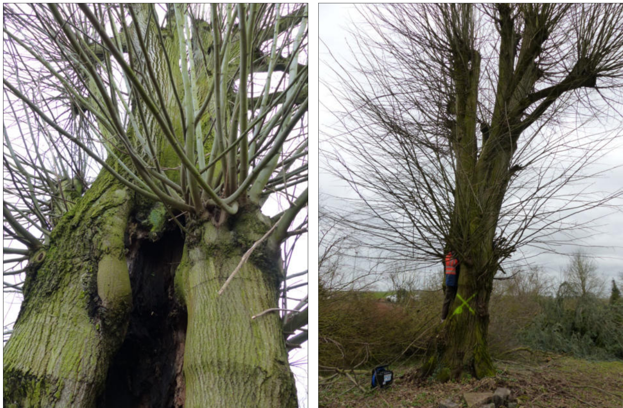
Abb. 1: Ulme mit Ausfaltung, welche mit Kanalendoskop untersucht wurden.
